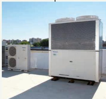
Neue Gaswärmepumpen. Die gasbetriebenen VRF-Systeme von Panasonic eignen sich hervorragend für Anwendungen, bei denen nur eine begrenzte elektrische Leistung zur Verfügung steht.
